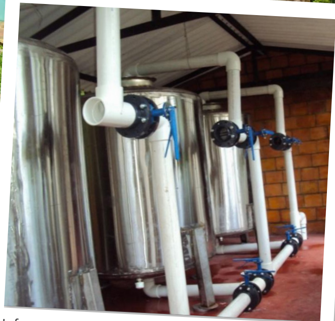
Infraestructura de la planta de tratamiento.
